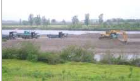
海老江地区河道掘削
