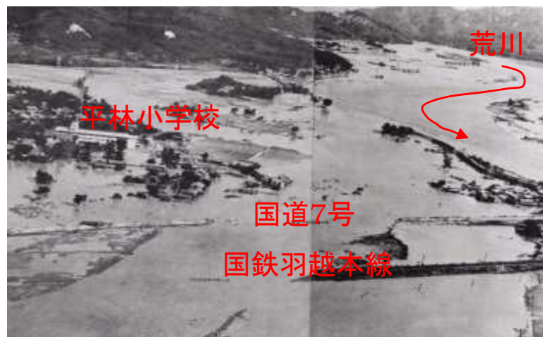
堤防決壊による浸水状況（旧神林村平林地区）
