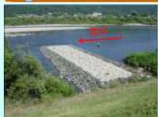
H13年度に設置した水制工の状況
