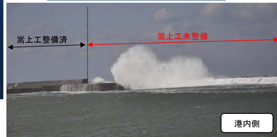
嵩上工未整備区間の越波状況
