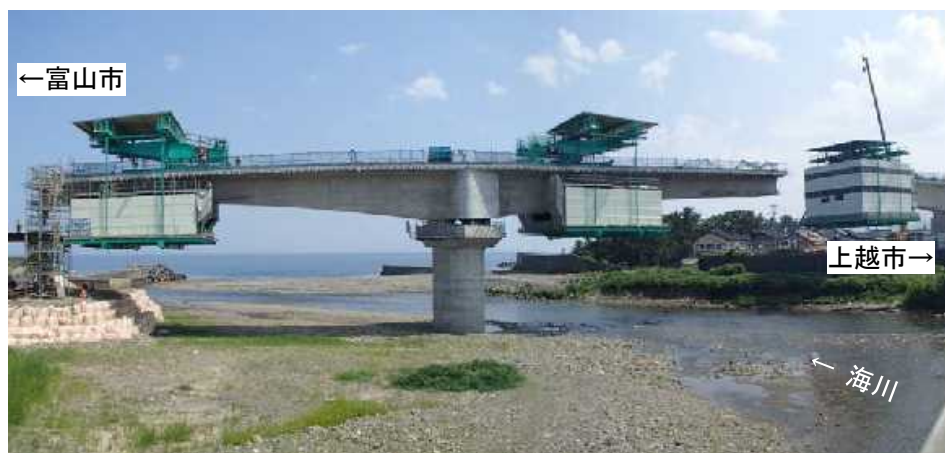
写真：海川高架橋（仮称）
