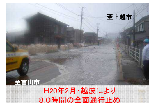
写真①:越波による通行止め なかしゆく (糸魚川市中宿周辺)
