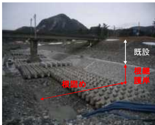
護岸の根継の状況（埋戻し前）
