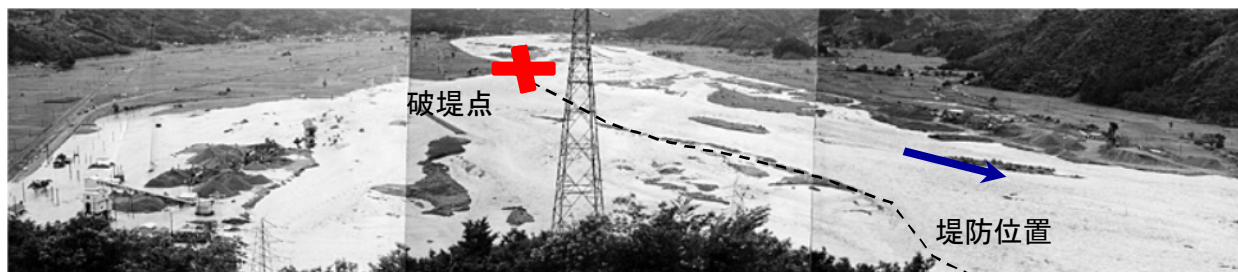
姫川右岸大野地区の堤防決壊状況 【昭和40年7月洪水】
