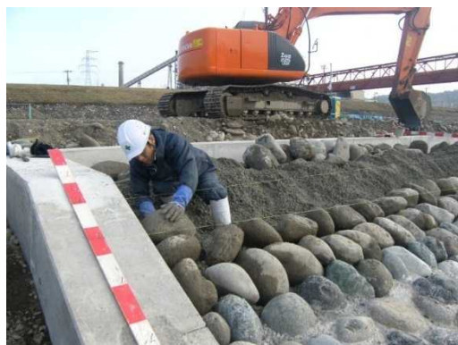
練石護岸の施工状況
