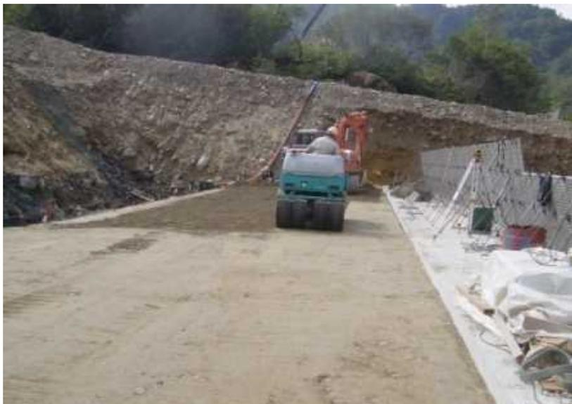
INSEM材の締め固め状況
