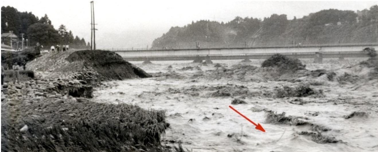
写真2-1 岩嶽野地先の洗掘による破堤状況 (S44年8月洪水)
