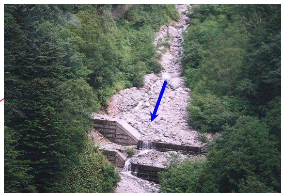
土石流を捕捉した床固工
