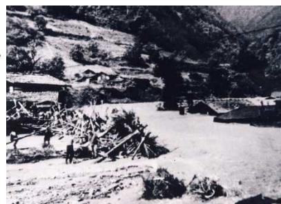
島々集落での土砂氾濫状況
