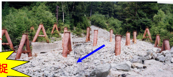
八右衛門沢床固の土砂捕捉状況
