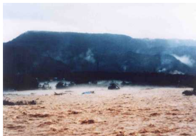
高瀬川本川の氾濫状況
