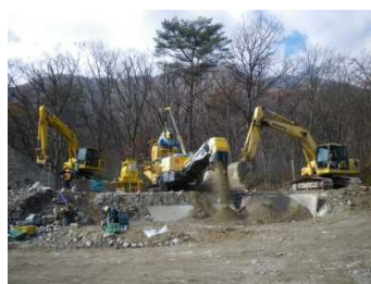
土砂とセメントの混合
