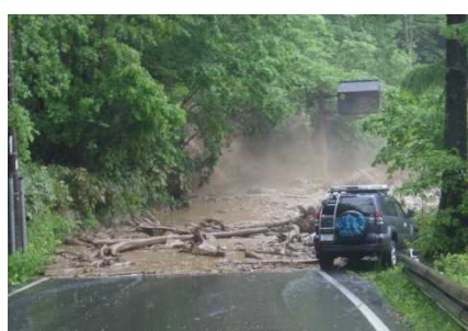
県道上高地公園線の土砂堆積状況
