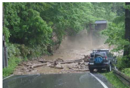
県道上高地公園線の道路閉塞状況 (平成23年)
