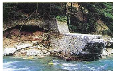
猫鼻砂防堰堤の決壊
