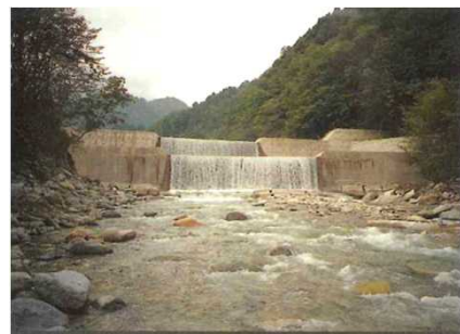
■丸山砂防堰堤 (鹿島川)
