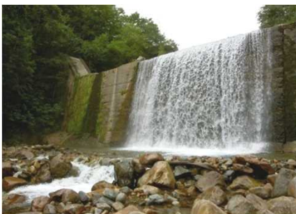
かごかわ ■簗川第一号砂防堰堤 (簗川)
