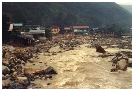
よりあいど 寄合渡地区での土砂氾濫状況
