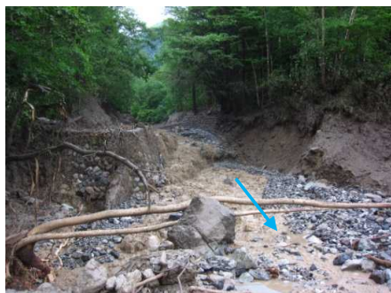
災害状況(谷出口より上流を望む)
