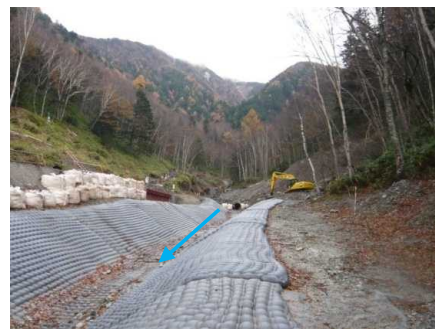
産屋沢渓流保全工
