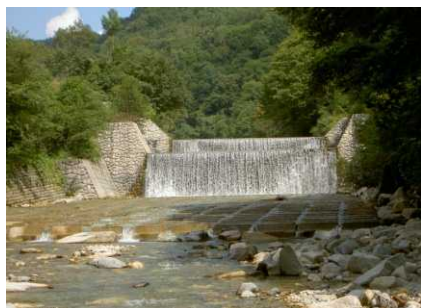
ねこはな ■猫鼻砂防堰堤 (鹿島川)
