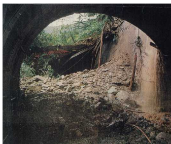
釜トンネル出口の土砂崩落 (平成11年)
