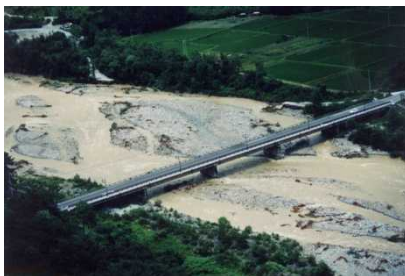
鹿島大橋付近の道路流失
