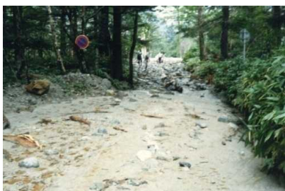
県道上高地公園線の土砂堆積状況
