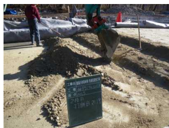
打ち継ぎ目処理
