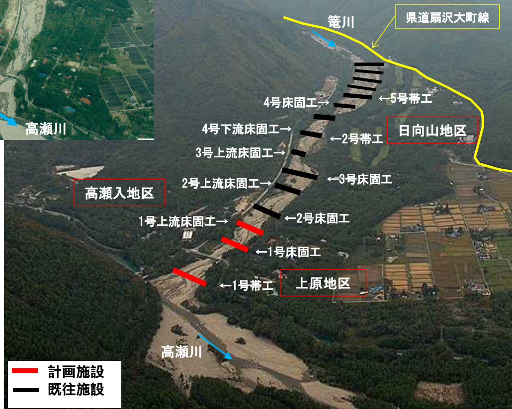
日向山床固工群全景
