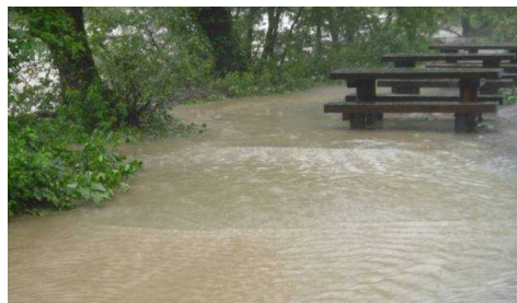
平成18年7月河童橋付近 河床上昇に伴う土砂堆積(上)と浸水被害(下)
