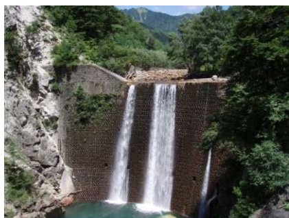
かまがふち ■釜ヶ淵上流砂防堰堤 (梓川本川)
