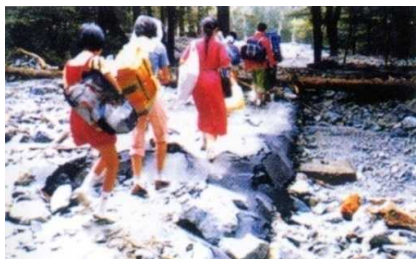
県道上高地公園線の寸断 (昭和54年)
