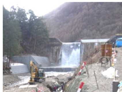
かなはら ■金原砂防堰堤 (奈川)
