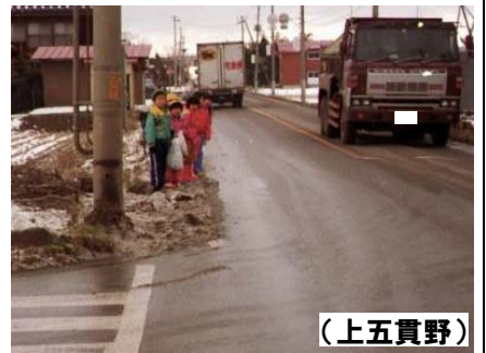
路肩が狭く、車と歩行者が近接
