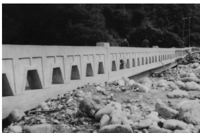
土石流で埋まった水神宮橋
