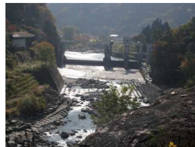
姫川第六ダム
