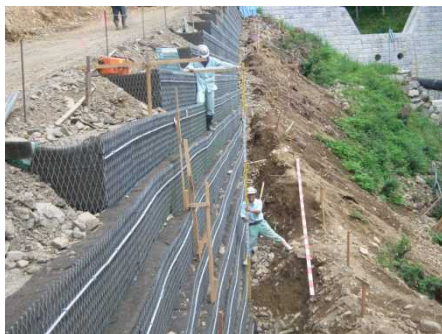
補強土壁工法による道路
