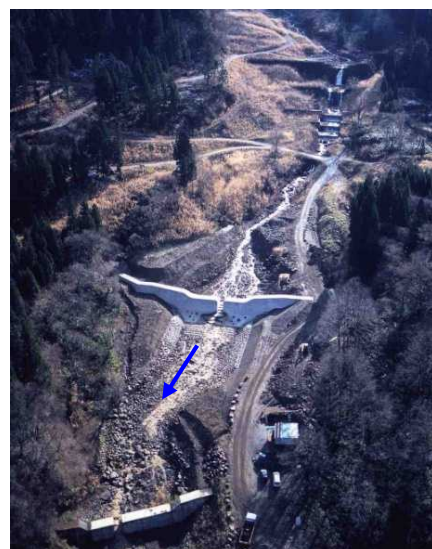
ねちがわ なかまたがわ ■根知川支川中股川の対策状況 河床に堆積した不安定土砂の流出を床固工群により抑制している。
