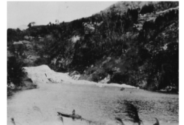
大崩壊により形成された天然ダム
