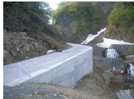
軽量盛土工法による道路
