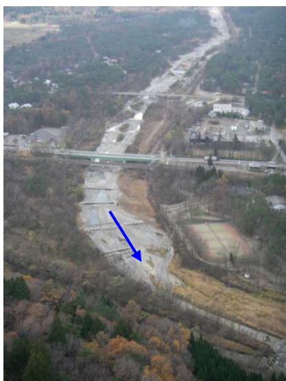
ひらかわ ■平川下流域の状況 保全対象の直上流に位置する河床に堆積した不安定土砂の流出を床固工等により抑制している。
