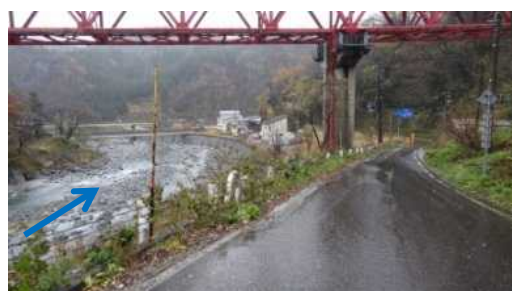
【現在の復旧状況】
