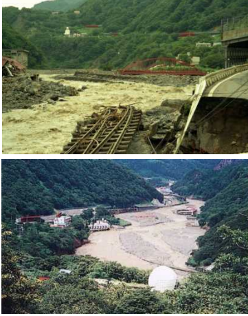
姫川温泉付近の被災状況
