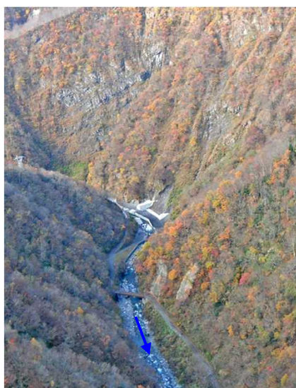
こたきがわ ■小滝川中流域の状況 河床に堆積した不安定土砂の流出を堰堤等により抑制している。
