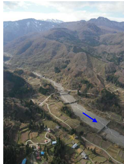
うらかわ ■浦川下流域の状況 浦川流域には、稗田山の大崩壊地があり、土砂流出が激しいが、砂防施設の効果により、適正に維持されつつある。
