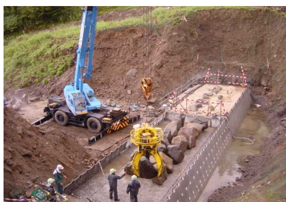
粗石設置状況
