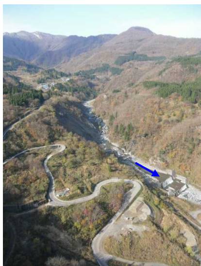
おおどころがわ ■大所川下流域の状況 砂防堰堤等を幹川に整備し、土砂流出・調節を図っている。
