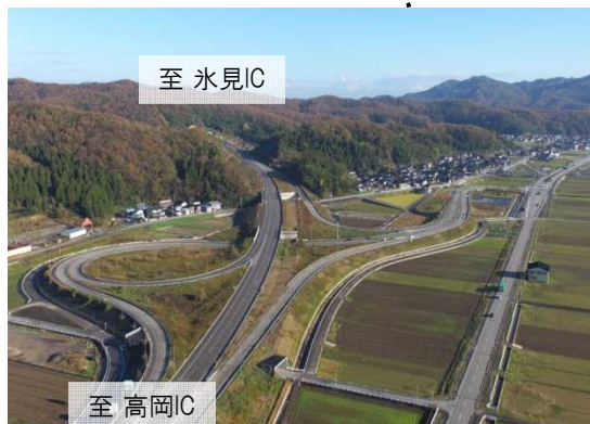
写真: 氷見高岡道路 高岡北IC全景 (氷見IC方面を望む)
