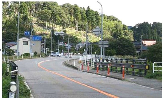
現道(刈安交差点)の状況(津幡北バイパス整備後)
