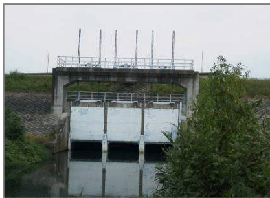
改築前の百々川樋門
