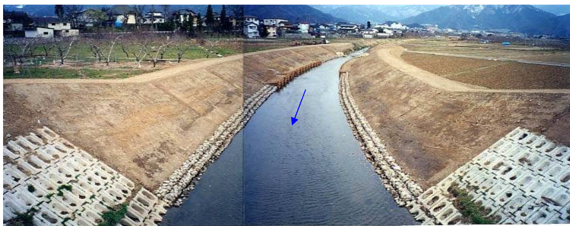
改修後の八木沢川（提供：長野県 平成14年4月撮影）
