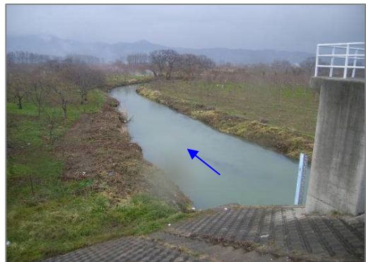
改築前：百々川樋門堤外水路
