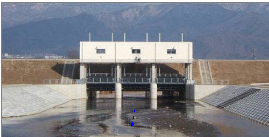
改築後の八木沢川樋門（平成 20 年 4 月撮影）
