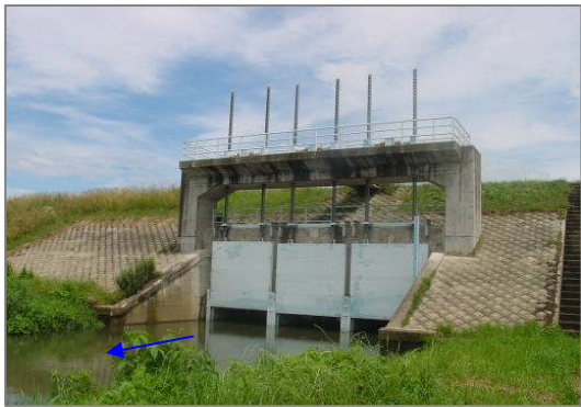
改築前：百々川樋門全景
