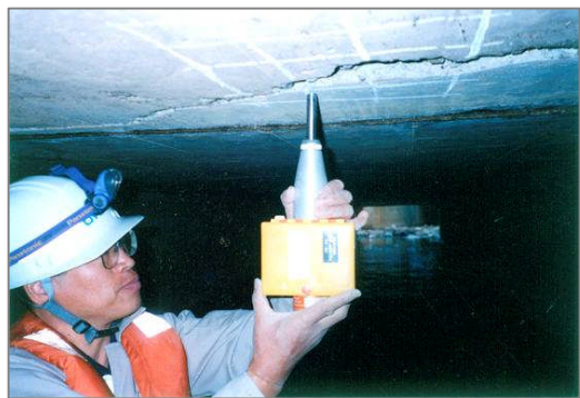
改築前：樋門内部のクラック
