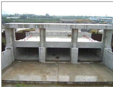
改築中の八木沢川樋門
