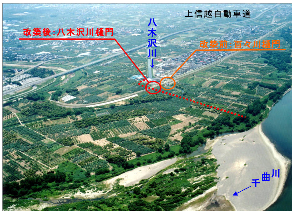
事業実施箇所の全景写真(平成 17 年 6 月撮影)
