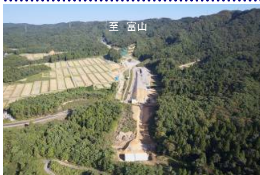
【整備中の七尾城山IC付近の状況】
