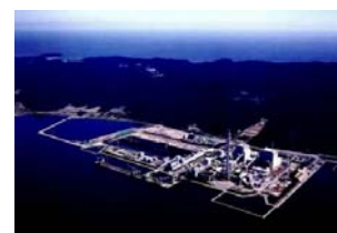
七尾大田火力発電所
