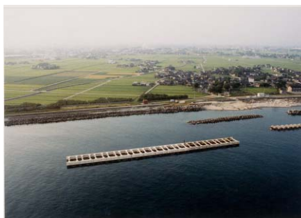
第3工区吉原 有脚式離岸堤
