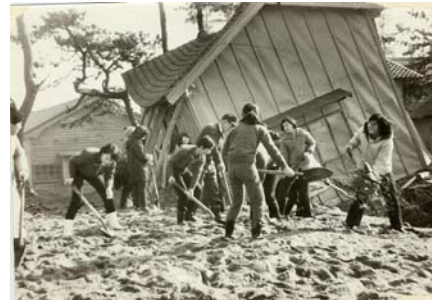
昭和45年2月復旧作業状況(入善町芦崎)
