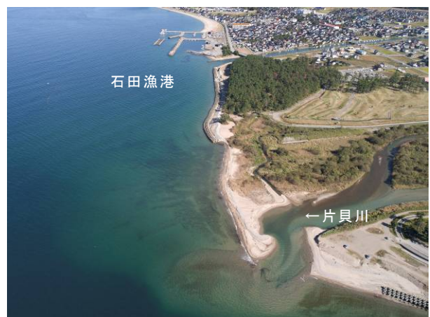
⑥黒部市大島地先(第6工区) 〔片貝川河口〕
