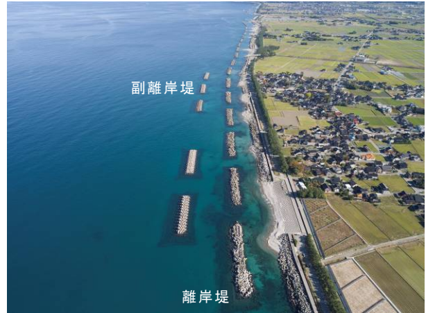
②入善町横山地先(第2工区)
