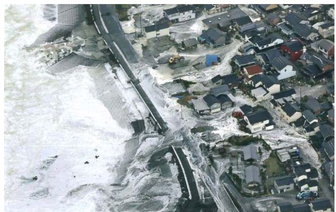
芦崎（入善漁港海岸）での越波状況 （読売新聞社撮影・提供）
