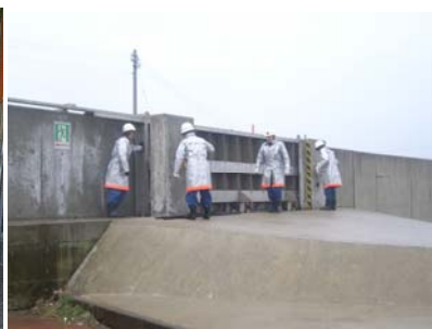
消防団による陸閘の閉門
