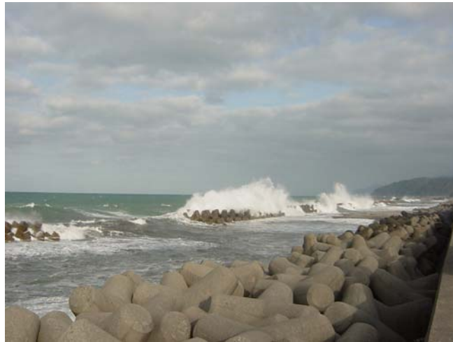
離岸堤の消波状況
