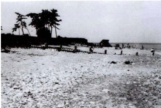
(No.159～No.157 付近) S35 撮影
