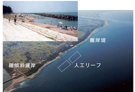
面的な海岸保全施設の整備(富山海岸)
