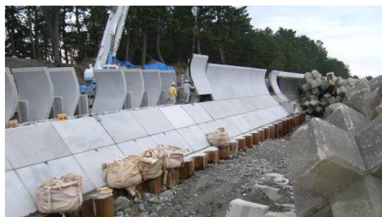
プレキャストコンクリートによる直立堤設置
