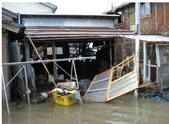
浸水による家屋の被災状況
