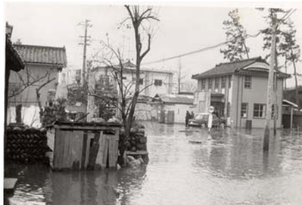
昭和45年2月浸水状況(入善町芦崎)
