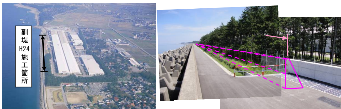
越湖 副堤 平成 24 年度施工箇所
