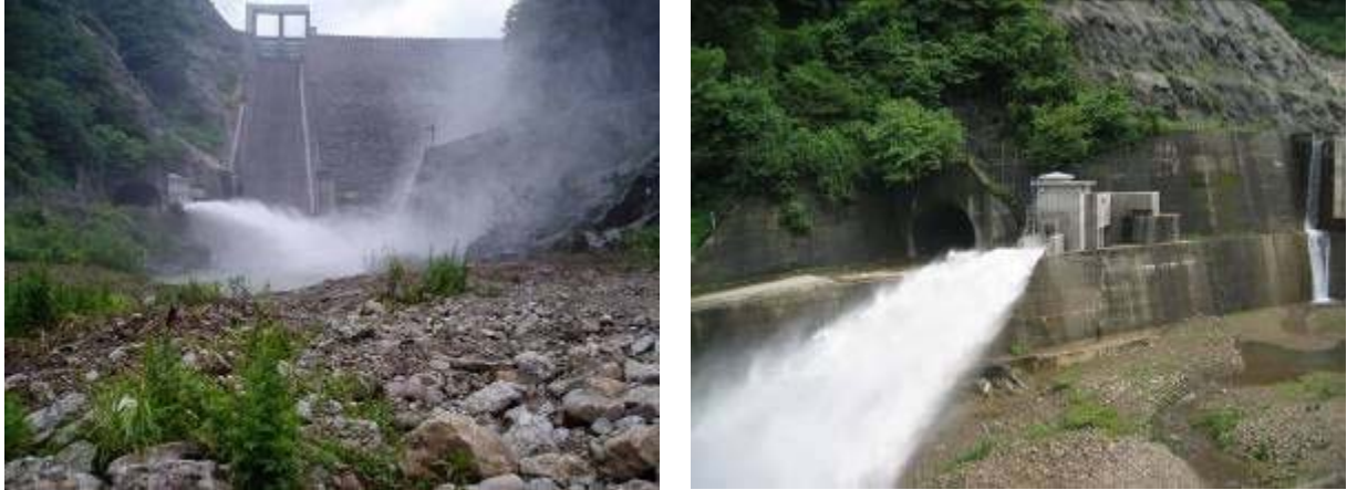
図2 新設した手取川ダム維持放流設備
