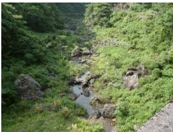
[ダム直下流の無水状況] (H13/8/3 撮影)
