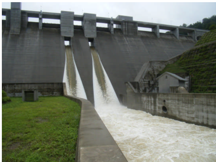
【横川ダム防災操作状況（H23.7.29洪水）】
