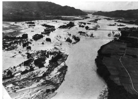
堤防が破堤し、集落は濁流に呑み込まれた （関川村上空より下流をのぞむ）
