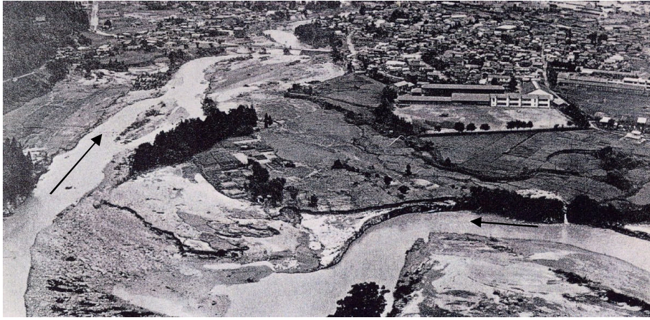
小国町の被害（横川筋） 出典：おおみず(小国町)
