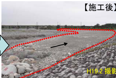
【急流河川対策（前腹付け工）】
