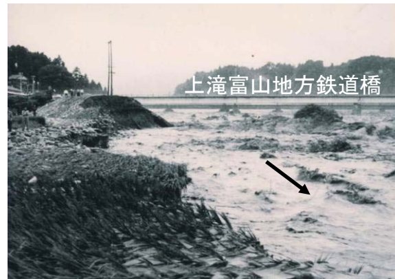
上滝富山地方鉄道橋 いわくらの岩嶺野地先での破堤状況
