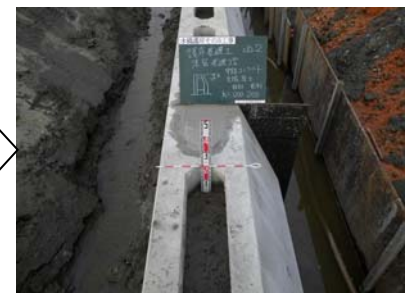
中詰め土砂・中詰め コンクリート投入
