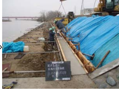
コンクリート打設
