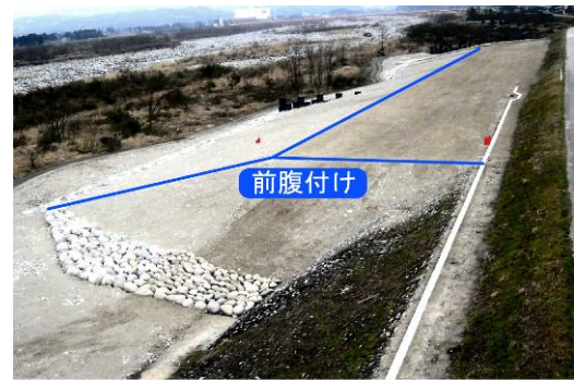
【急流河川対策（前腹付け工）】
