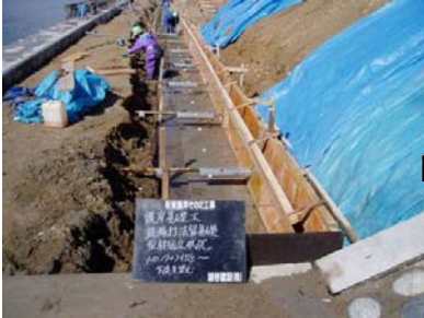
型枠組み立て
