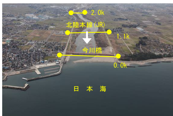
管理区間下流端付近
