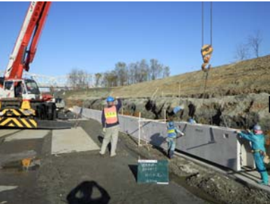
プレキャスト法留め 基礎据え付け
