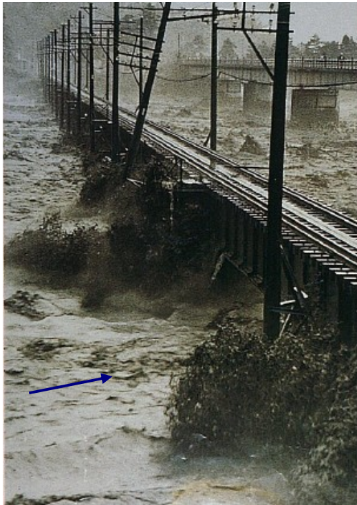
立山町上滝富山地方鉄道橋
