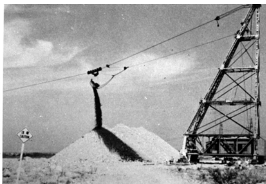
タワーエクスカーベーター
