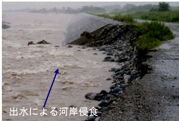
河床の局所洗掘により傾く水制工
