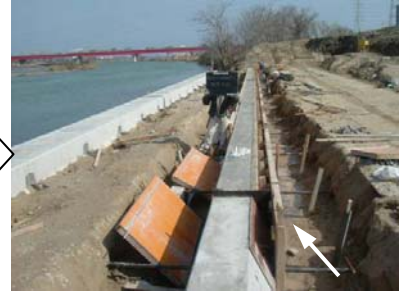
型枠脱枠
