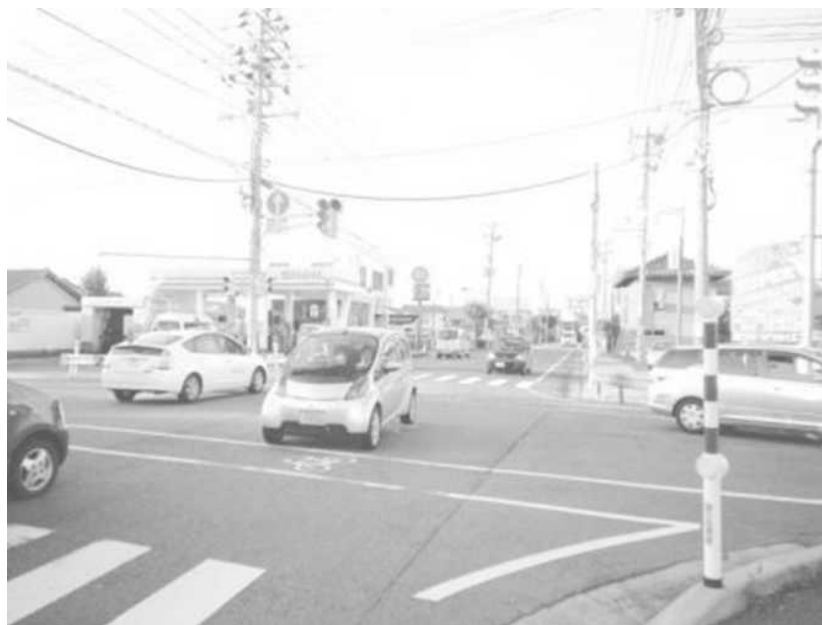
交通量が4割減少し、交通円滑化、沿道環境改善が図られた現道部
