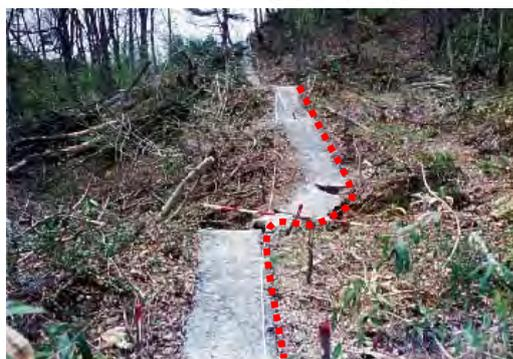
④地すべりにより生じた観測通路のずれ
