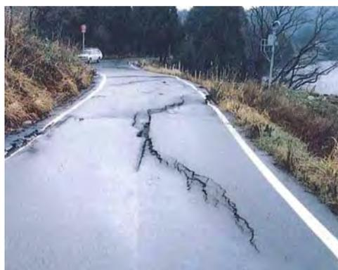
②地すべりにより発生した県道上の亀裂
