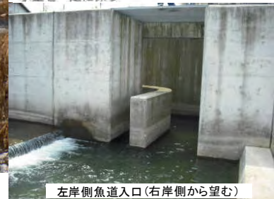
左岸側魚道入口(右岸側から望む)
