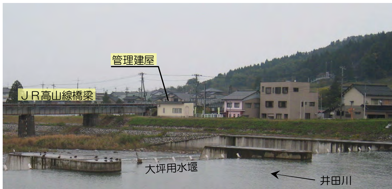
大坪用水堰の管理建屋とその周辺景観
