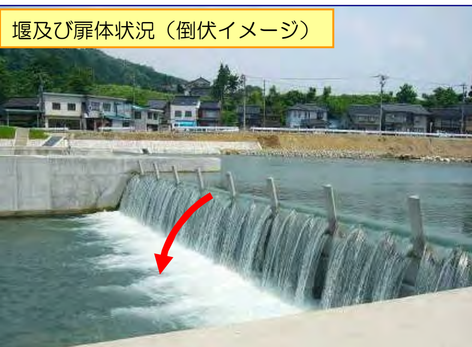
新堰（可動堰）の洪水時操作
