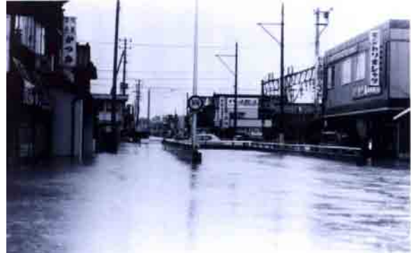
昭和53年鵜川洪水による柏崎駅周辺の浸水被害（新潟県資料）
