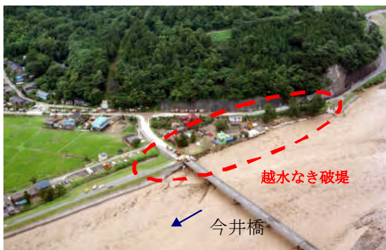
洗掘による破堤状況（糸魚川市上刈地先）
