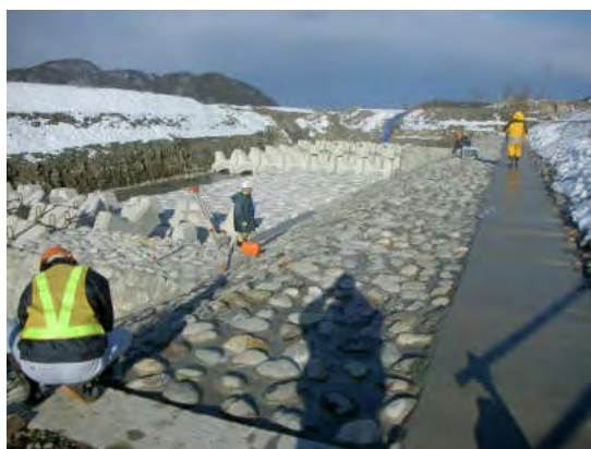
練石護岸施工状況
