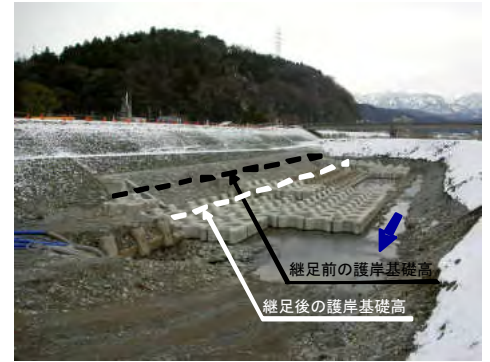
護岸根継工事の状況
