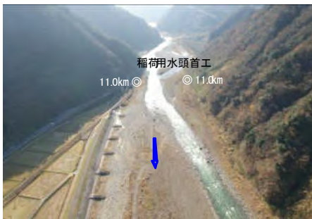
稲荷用水頭首工付近 (11.0 km)
