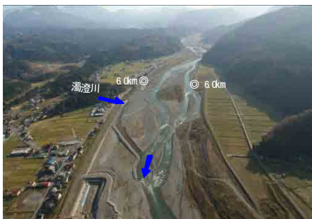
濁澄川合流点付近 (6.0 km)
