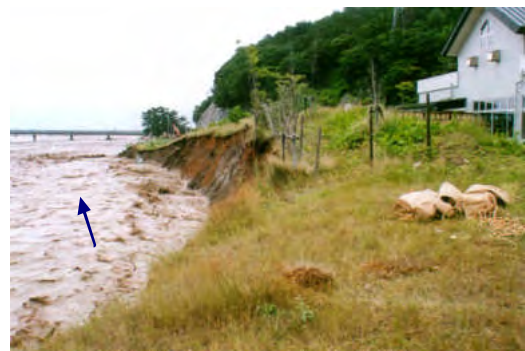
堤防欠壊状況（糸魚川市大野地先）
