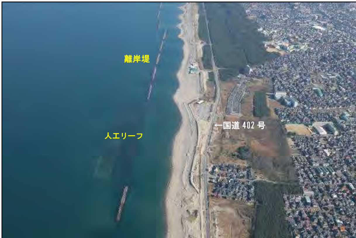
写真 4 有明浜工区斜め空中写真（2010年【平成22年】撮影）
