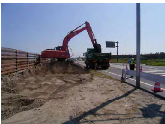
国道402号積込運搬状況 (道路事業：新潟市)
