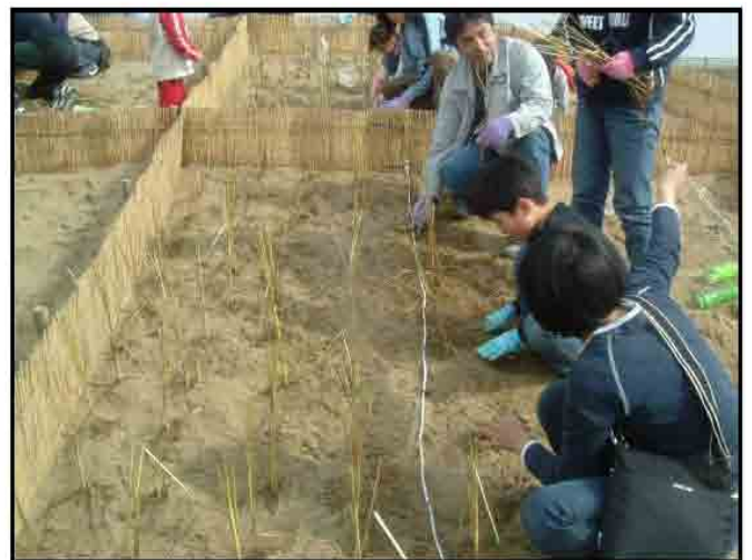
植苗状況（砂浜安定工）
