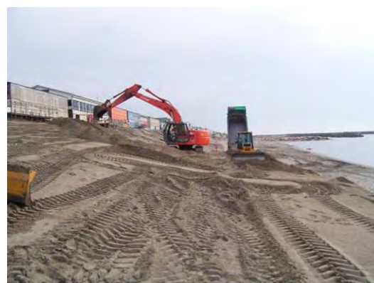
敷均し状況 (海岸事業)
