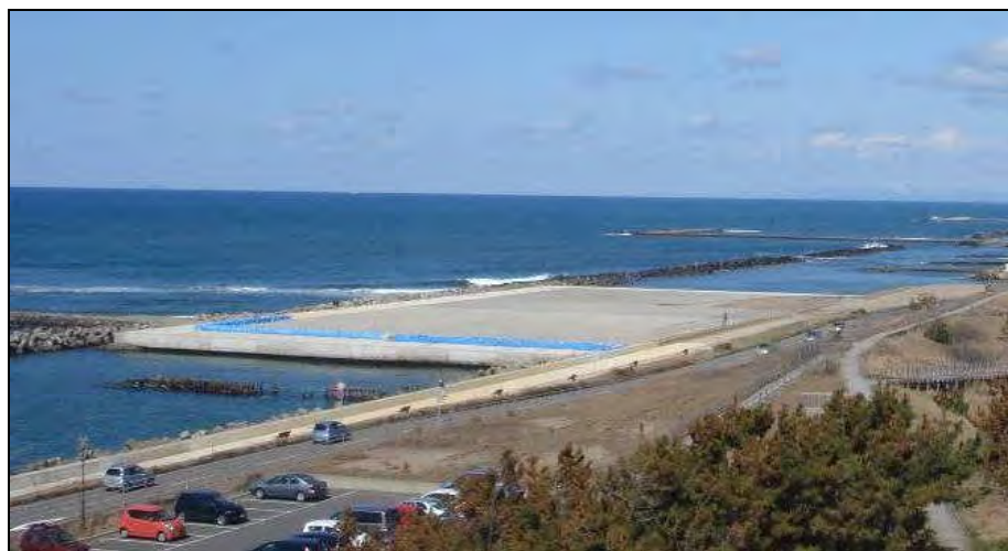
ブロック製作ヤード
