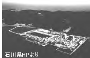
石川県HPより 七尾大田火力発電所
