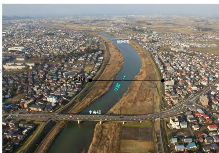
河道掘削実施箇所航空写真 （稲田橋～中央橋付近）
