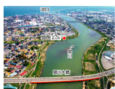
関川大橋下流
