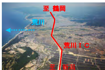
日本海沿岸東北自動車道
