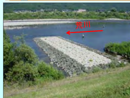
H13年度に設置した水制工の状況
