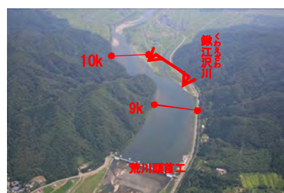
荒川頭首工(河口より 9.0km) 付近
