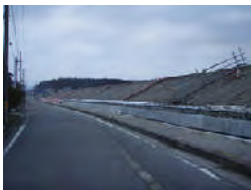
H20 上関地区堤防強化対策状況 (ドレーン工設置)
