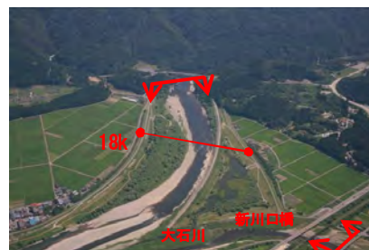
大石川合流部(河口より 17.5km) 付近
