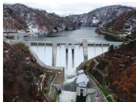
H19.12 横川ダム試験湛水状況
