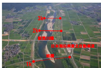
旭橋(河口より 1.0km) 付近
