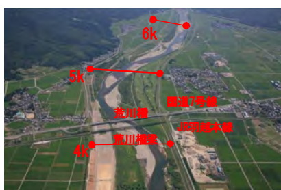
荒川橋(河口より 4.0km) 付近
