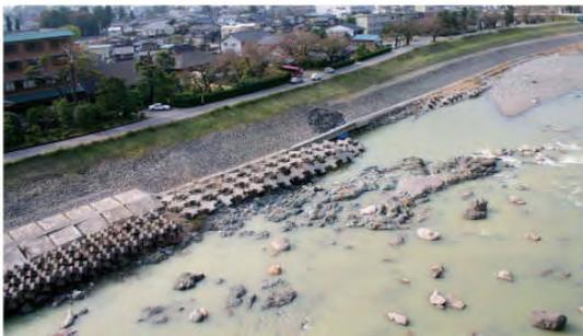
堤防護岸の決壊及び根固め流失(砺波市 庄川町金屋地先)
