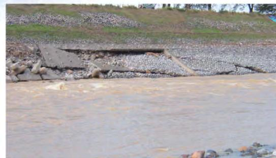
堤防護岸の決壊及び根固め流失(砺波市 庄川町青島地先)
