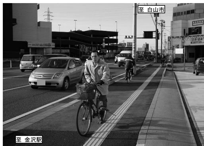
整備後 (横川交差点付近)
