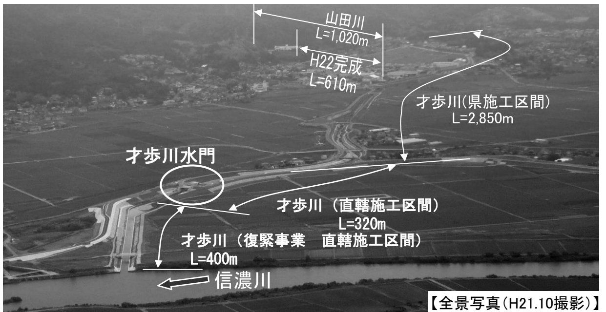
図6. 全体施工状況
