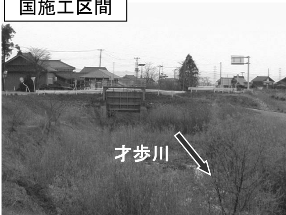
写真3. 施工前：旧逆流防止水門 (H14)
