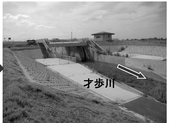
写真4. 才歩川水門完成 (H17)
