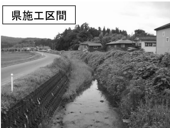
写真5. 施工前：才歩川上流 (H15)
