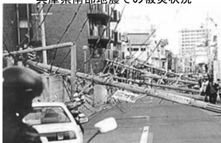
電柱の倒壊による道路の閉塞が発生
