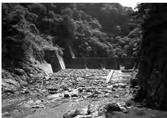
尾添川第 1 号砂防堰堤
