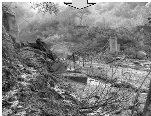
登山道の吊り橋流出
