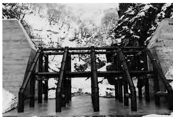
中ノ川下流第 2 号砂防堰堤
