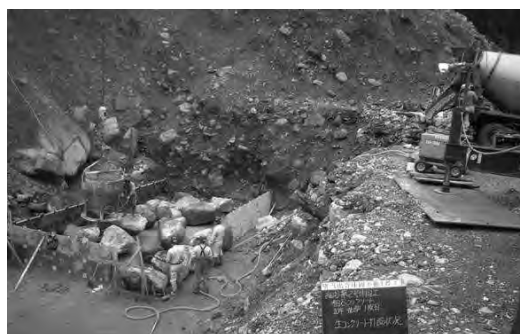
粗石コンクリート打設状況
