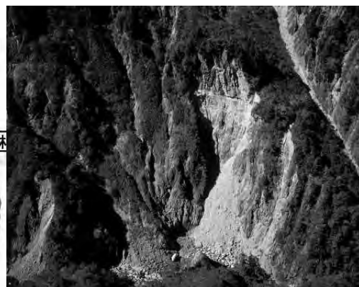
尾添川上流地獄谷の荒廃状況
