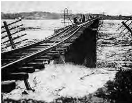
手取川鉄橋(濁流による洗掘)
