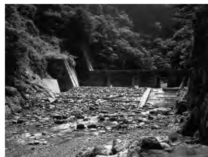
尾添川第 1 号砂防堰堤 (平成 9 年完成)
