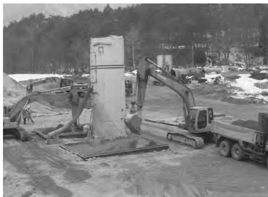
①現地発生材(土砂)とセメントの混合
