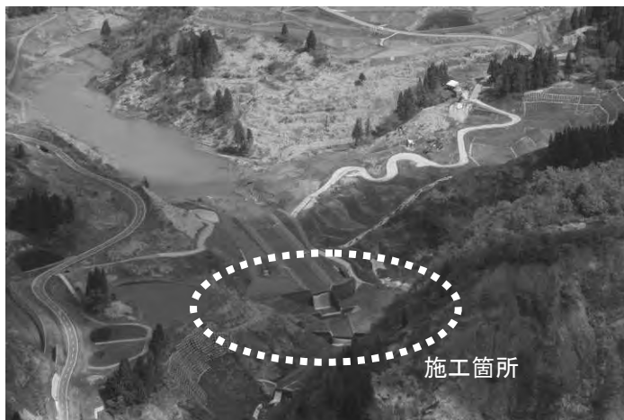
砂防堰堤施工後の寺野地区の状況
