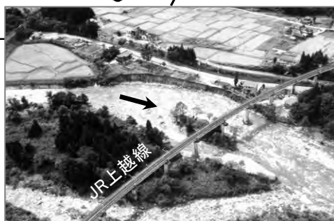
平成10年9月 魚野川上流の河岸侵食
