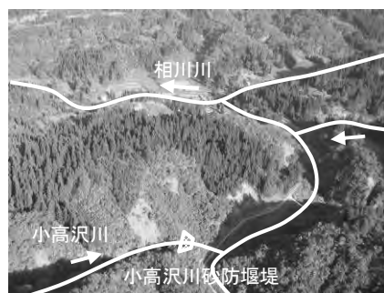
小高沢川砂防堰堤
