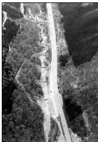
大川床固工群
