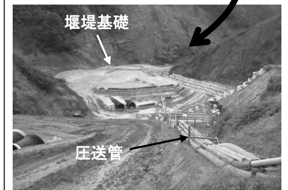
圧送管によるセメントミルクの運搬
