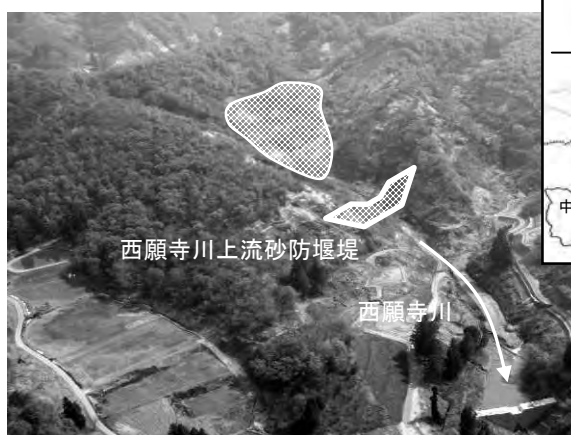
西願寺川上流砂防堰堤
