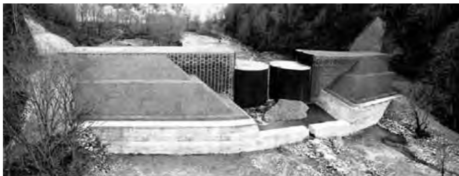
登川上流第2号砂防堰堤（全景）
