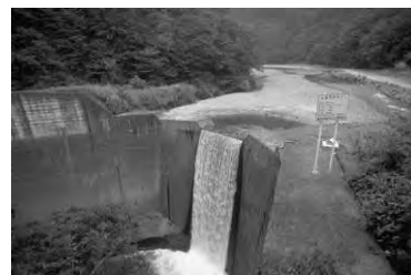
上結東砂防堰堤(中津川) (昭和36年完成)
