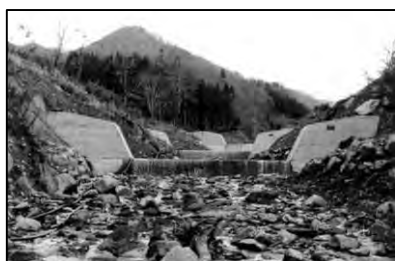
小赤沢第14号砂防堰堤
