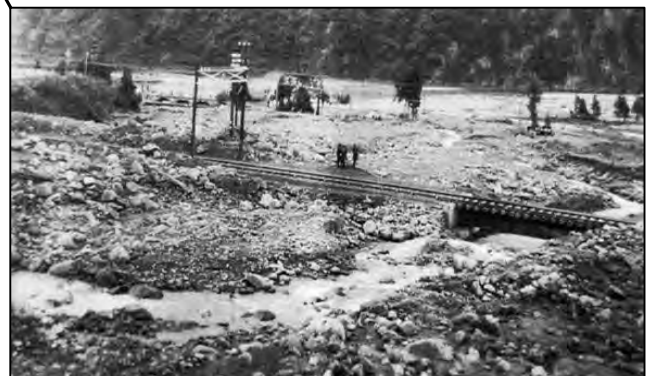
昭和10年9月 湯沢町付近の旧国鉄上越線の被害状況
