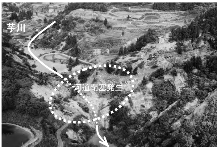
平成16年新潟県中越地震により、河道閉塞が発生した寺野地区
