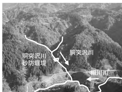
胴突沢川砂防堰堤
