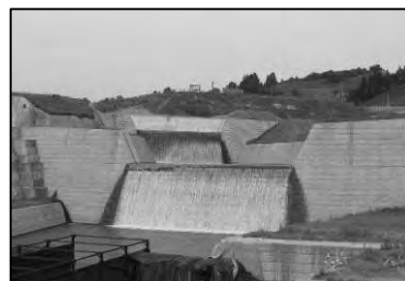
東竹沢第1号砂防堰堤(芋川) (平成19年1月完成)
