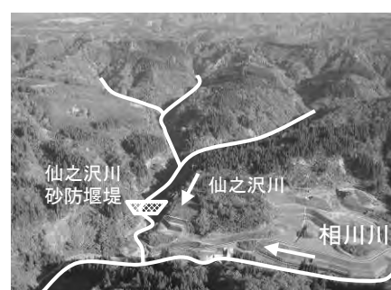
仙之沢川砂防堰堤
