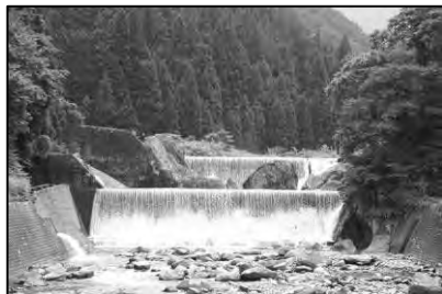
高石砂防堰堤(水無川)
