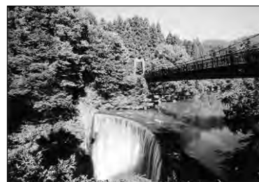
大源太川第1号砂防堰堤 (昭和14年完成)
