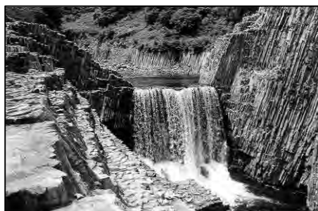
七ツ釜下流砂防堰堤
