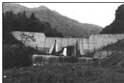
硫黄川上流第2号砂防堰堤
