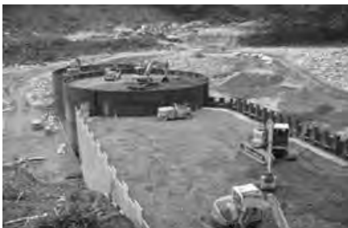
鋼製セル、ダブルウォールへの発生土の中詰め
