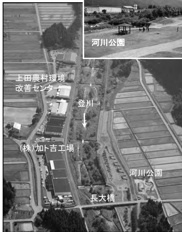
登川流路工 施工後の状況
