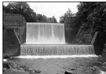
五味沢砂防堰堤(破間川) (昭和48年完成)
