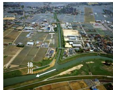
八丁川合流部(河口より 4.6km) 付近
