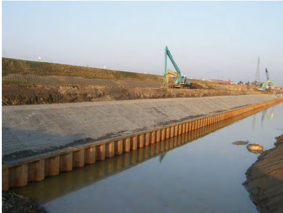
広幅鋼矢板(ハット型)の施工状況
