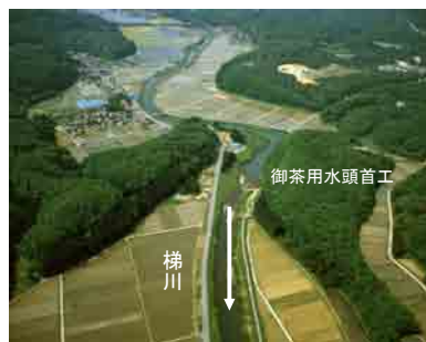
御茶用水頭首工(河口より 12.2km) 付近
