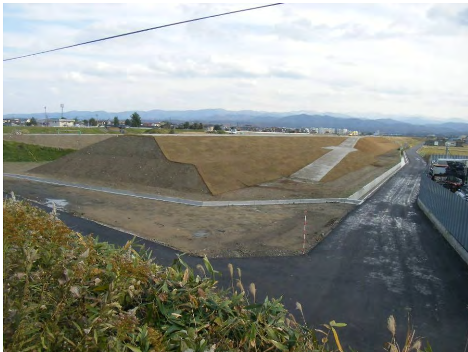
河道掘削残土の有効利用(築堤材)
