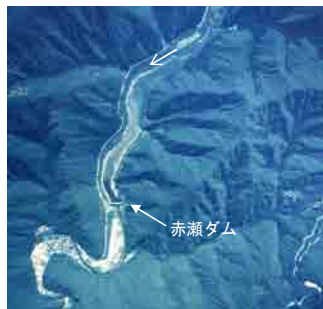
赤瀬ダム(河口より 27km)上流付近
