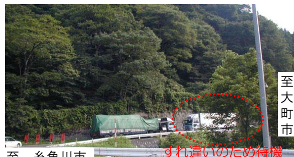
【写真2：大型車同士のすれ違い時に いずれか一方がカーブ手前で待機】
