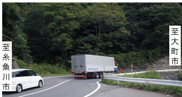
【写真1：大型車が対向車線を利用して走行】
