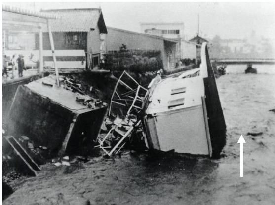
井田川 富山市八尾町下新町地先 護岸が欠壊し建物が水中に転落。
