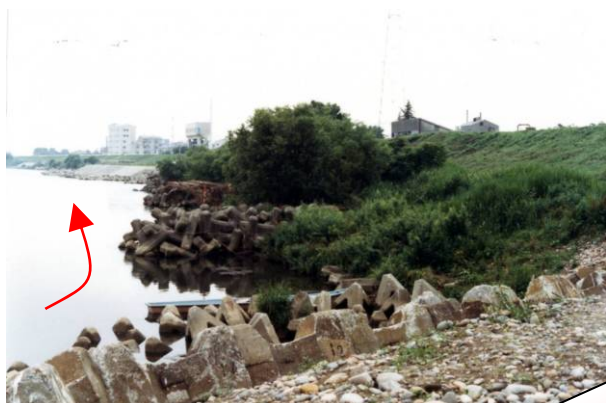
神通川 牛島地区 施工前
