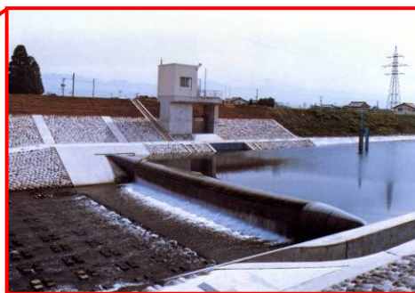
松川浄化用水取水堰(ラバーゲート)と取水樋管
