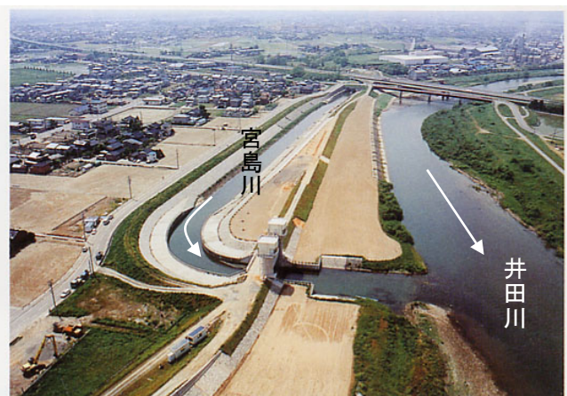
宮島川新設部・合流点付近
