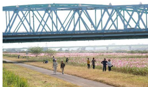
平常時利用状況（有沢橋）
