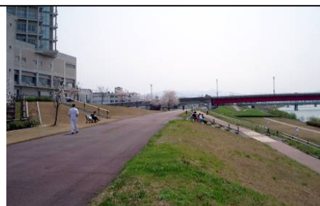
整備後利用状況 (富山赤十字病院前) 高水敷でのキャッチボールや散策などに利用されている
