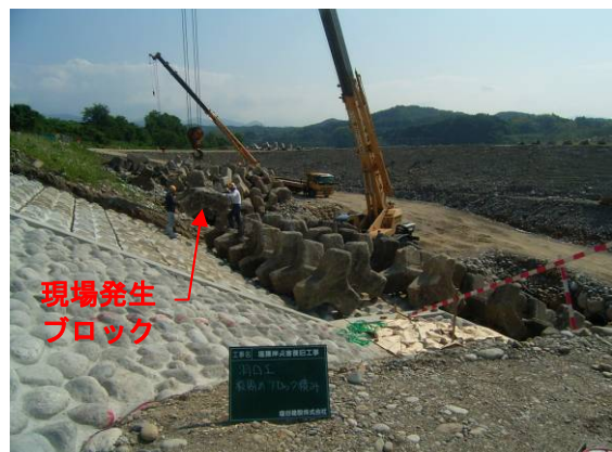
現場発生ブロックの羽口工への再利用状況
