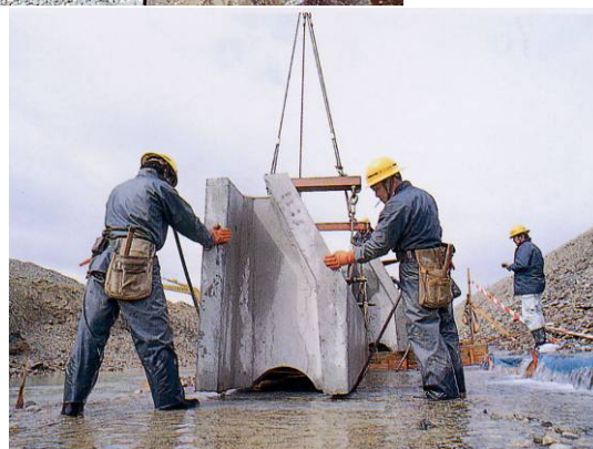
プレキャスト法留工施工状況（コスト削減）
