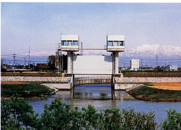
平成 11 年度完成 宮島川水門
