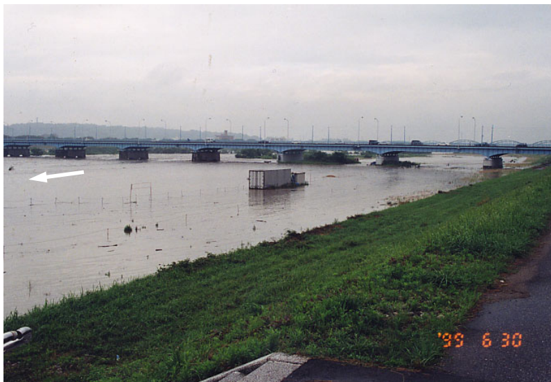
高水敷上のゲートボール場が冠水。
