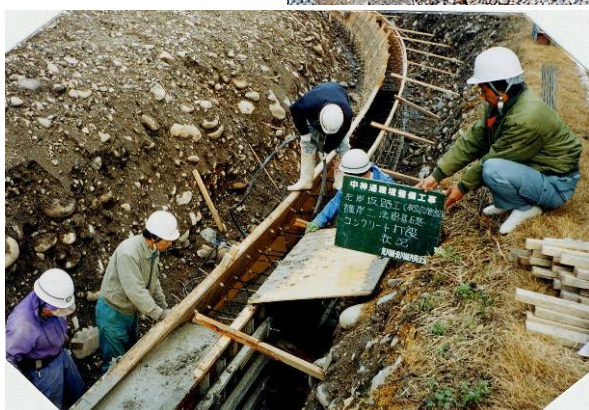
現場打ち法留工施工状況（従来）
