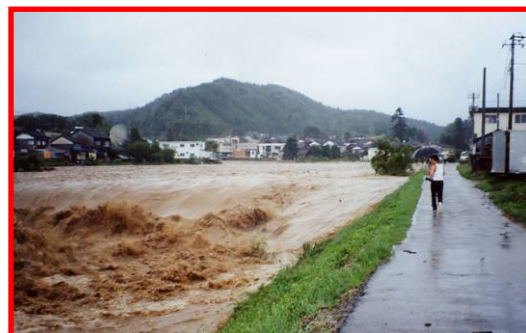
平成 2 年 9 月洪水（約 620\text{m}^3/\text{s} ：杉原橋地点） 計画高水流量の約 45% 程度が流下したときの 大坪用水堰の状況
