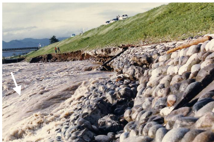
上段写真赤丸箇所の近景
