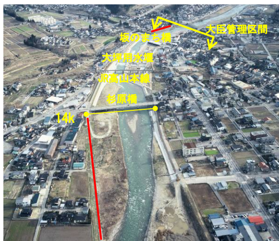
河積不足の解消（井田川上井田・井田地区）
