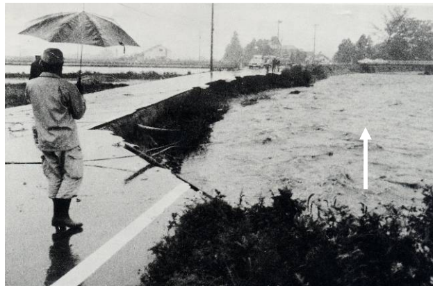
熊野川 富山市東福沢地先 川沿いの道路は濁流にえぐられ欠壊し 通行不能に。
