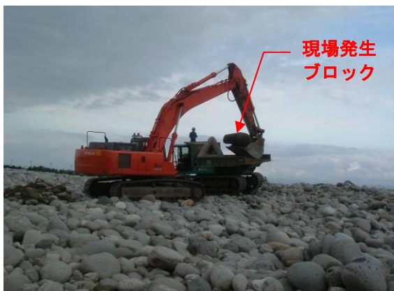
現場発生ブロックの撤去状況
