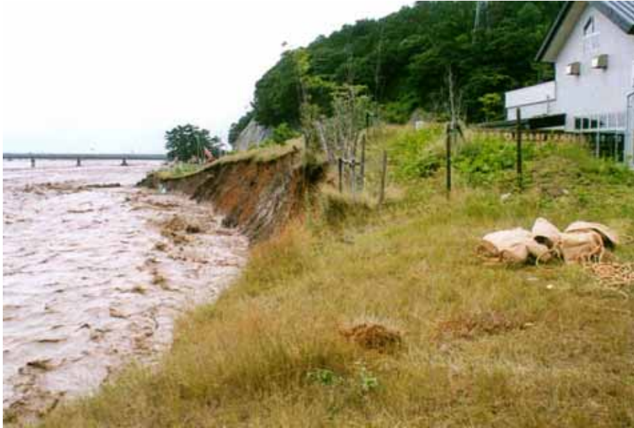
堤防欠壊状況（糸魚川市大野地先）
