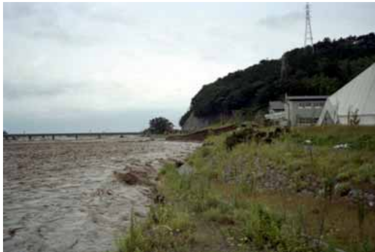
築堤・引堤前（H7.11洪水時）
