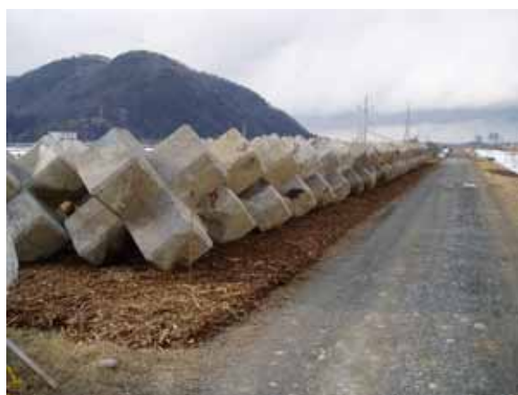
側帯ブロック下敷均し
