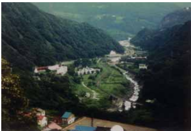
土砂堆積前（洪水前） （糸魚川市平岩地先）
