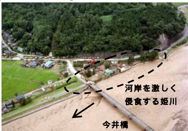
河岸洗掘による破堤状況（糸魚川市上刈地先）
