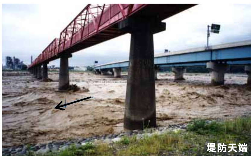
平成 7 年 7 月 11 日洪水 - 出水状況 - 糸魚川市須沢地先
