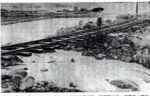
濁流に濁床を築われ田づりになった大木線の線路一區間を越す上流で
