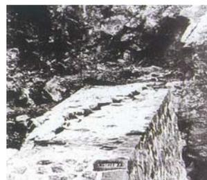
写真2-1 甚之助谷5号堰堤の亀裂(S3)
