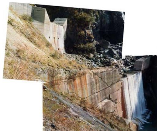
写真2-2 柳谷第3号砂防えん堤の亀裂(S54)
