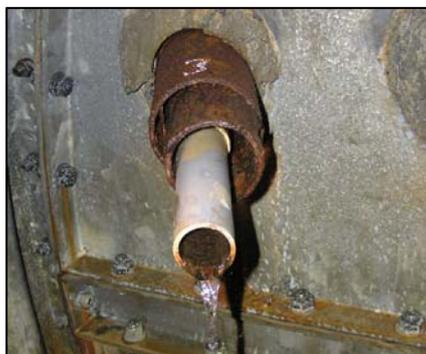
図7-2 VP管(硬質塩化ビニール管)
