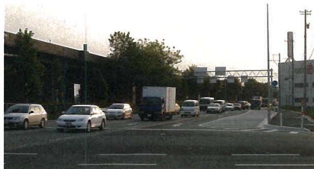
②左折車線設置状況(上り線)
