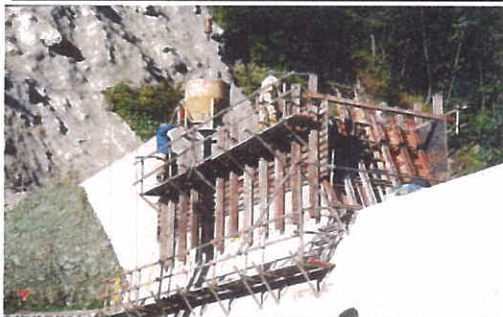
通常型枠の施工状況
