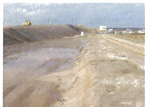
日本海沿岸道路の盛土材として活用
