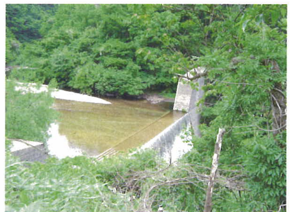
女川第1号砂防堰堤
