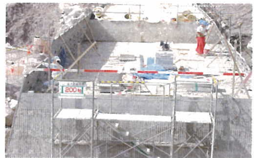
残存型枠工法
