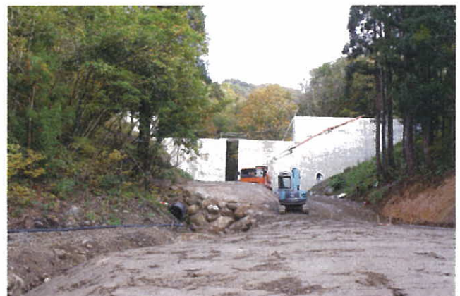
田麦沢砂防えん堤
