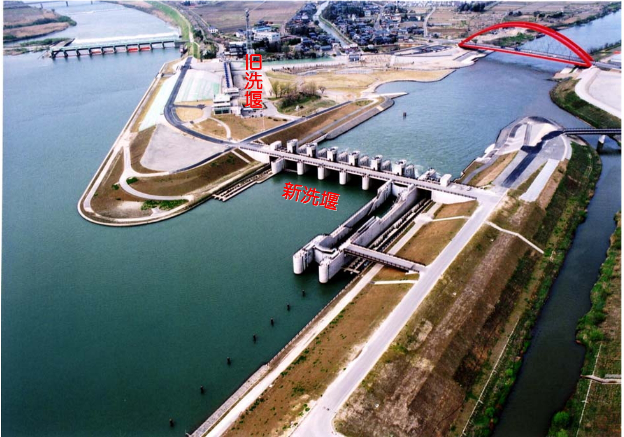
新洗堰の状況
