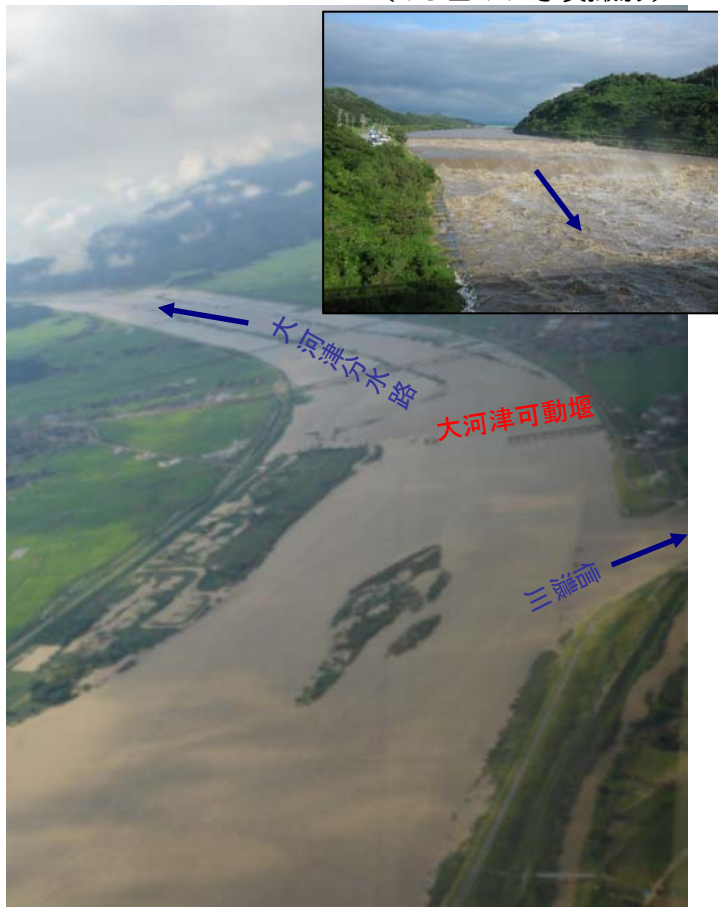
大河津分水路の状況（H18.7.19 16時頃撮影）
