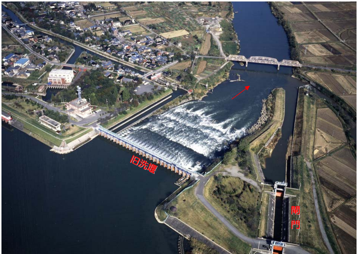
旧洗堰の状況
