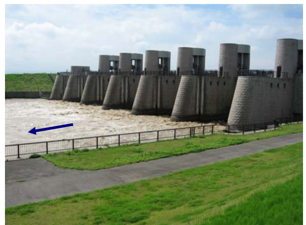
下流左岸より洗堰を望む(20日10時頃撮影) 【信濃川下流へ270m³/sを放流】
