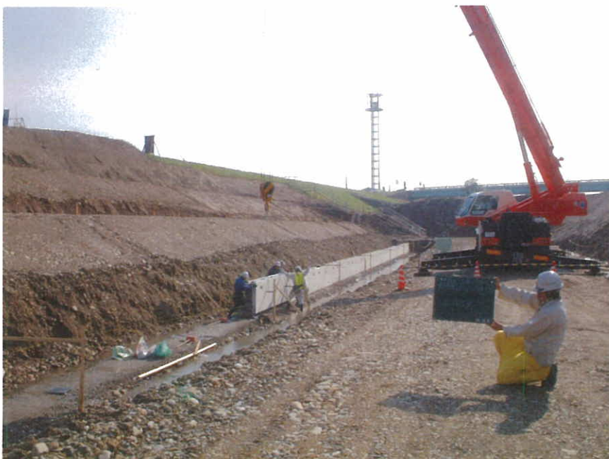
小矢部市経田地先における施行状況
