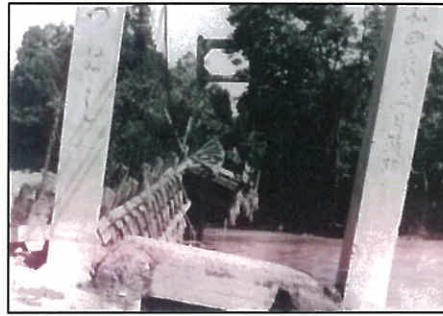
昭和28年9月洪水 34.8k付近、清水橋落橋
