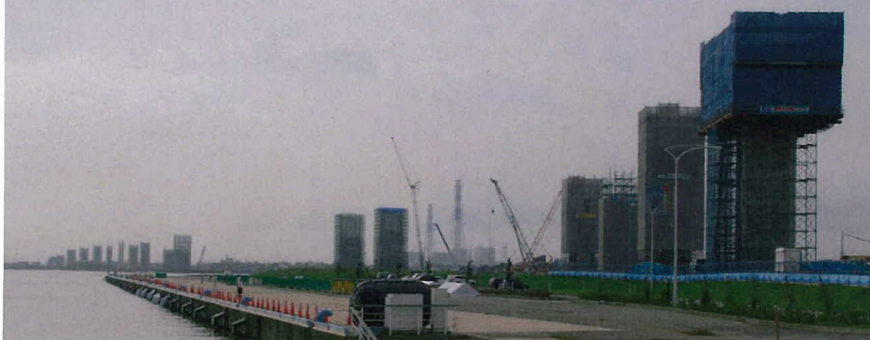
【工事区間現況】
