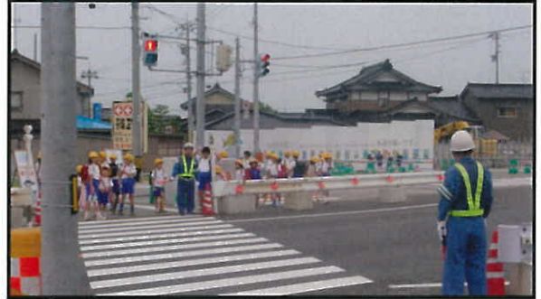
通学状況（整備中区間）
