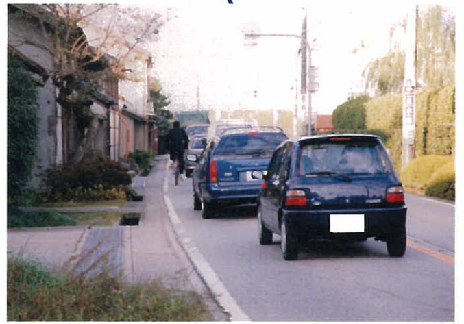
現道の状況：歩道が無く危険な状況（砺波方面を望む）
