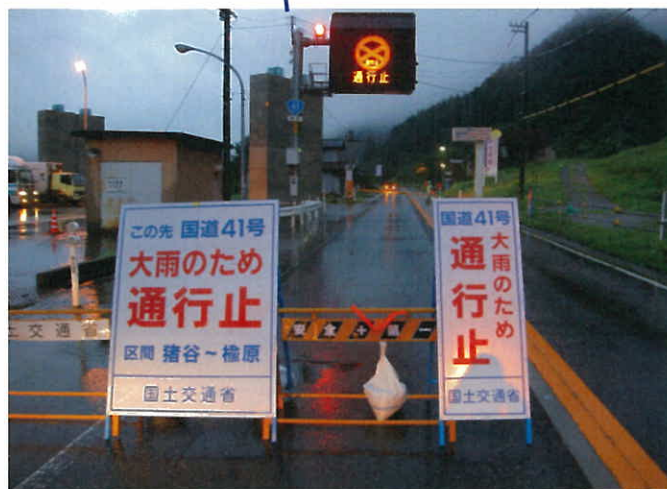
現道の状況：雨量規制実施 (H18. 7. 19) (高山市方面を望む)
