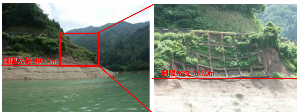
法面整備施工箇所（平成 17 年 8 月撮影）
