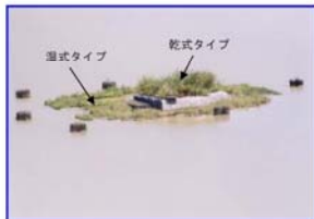
写真：下流側浮島 (全体の長さは約36m、幅は約25m)
