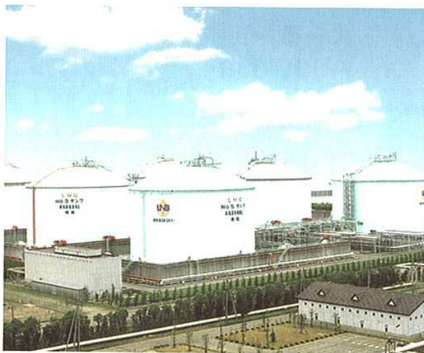
〔貯蔵施設〕 LNGタンク
