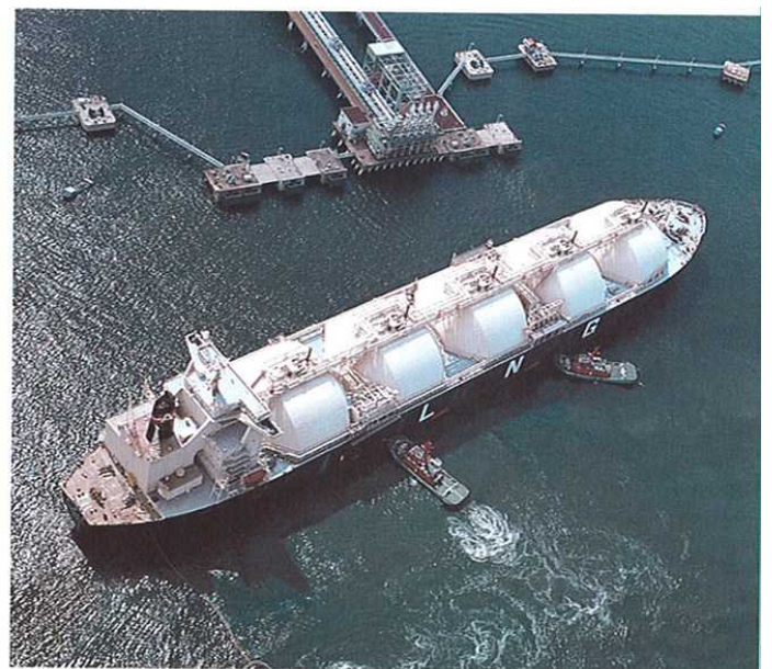
栈橋接岸状況
