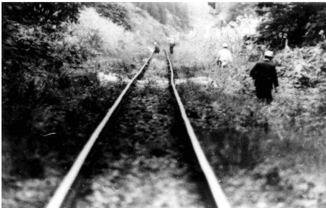
地すべりによる線路の変形
