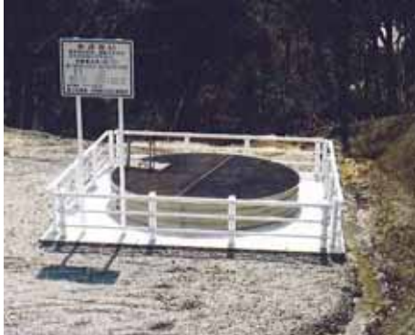
集水井工 外観
