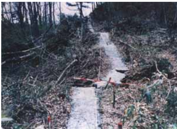
平成 4 年 4 月 地すべりにより生じた観測通路のずれ
