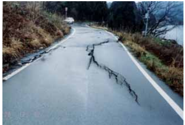
昭和 57 年 地すべりにより生じた県道上の亀裂
