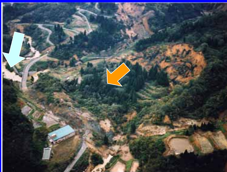
中越地震 東竹沢地区の災害事例 (平成16年10月23日発生)
